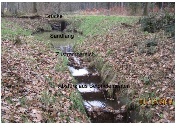
Abb. 2: Sohlrampe aus Beton-Hohlkasten-Profilen
